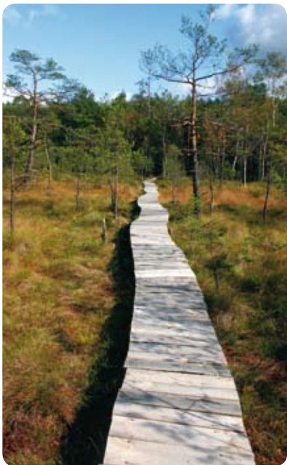
Fot. 52. Kładka przez torfowisko, zbudowana w rezerwacie Bagno Kusowo (Nadleśnictwo Szczecinek)
