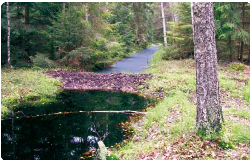
Fot. 65. Zastawka – dębowa ścianka szczelna zainstalowana na rowie
