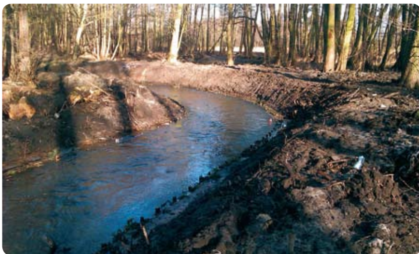
Fot. 29. Tzw. prace utrzymaniowe na rzece Postomi. Szkody dotyczą nie tylko samego koryta (uproszczenie morfologii) lecz przylegających do niego łągów i torfowisk (przesuszenie, zmiana reżimu wodnego w wyniku przyspieszenia spływu wody) Fot. R. Stańko
