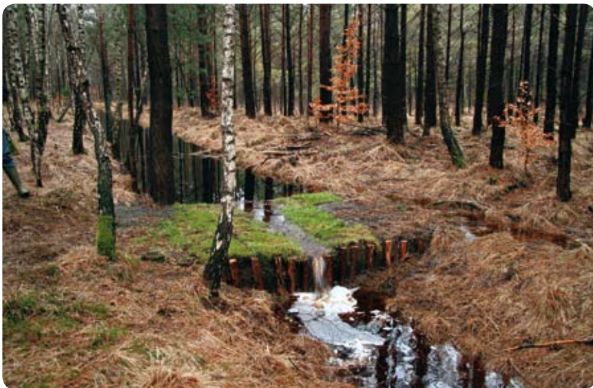
Fot. 60. Przegroda drewniano-torfowa: skuteczny i trwały sposób piętrzenia
