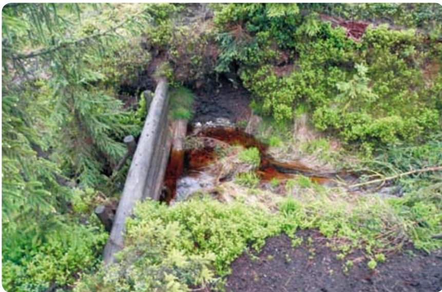
Fot. 41. Prosta konstrukcja blokująca odpływ powierzchniowy wody z pobliskiego terenu. Woda gromadzi się przed przegrodą i powoli przesącza się w dół – unika się wtedy gwałtownego odpływu powierzchniowego co w górach jest naturalnym skutkiem opadów
