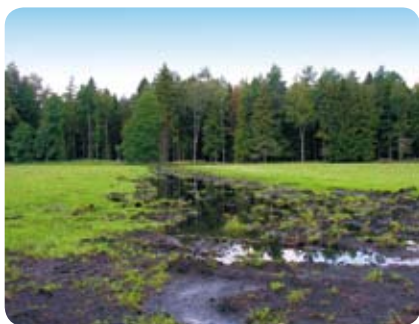
Fot. 66. Zasypanie rowu rodzimym materiałem – efekt tuż po wykonaniu prac ziemnych
