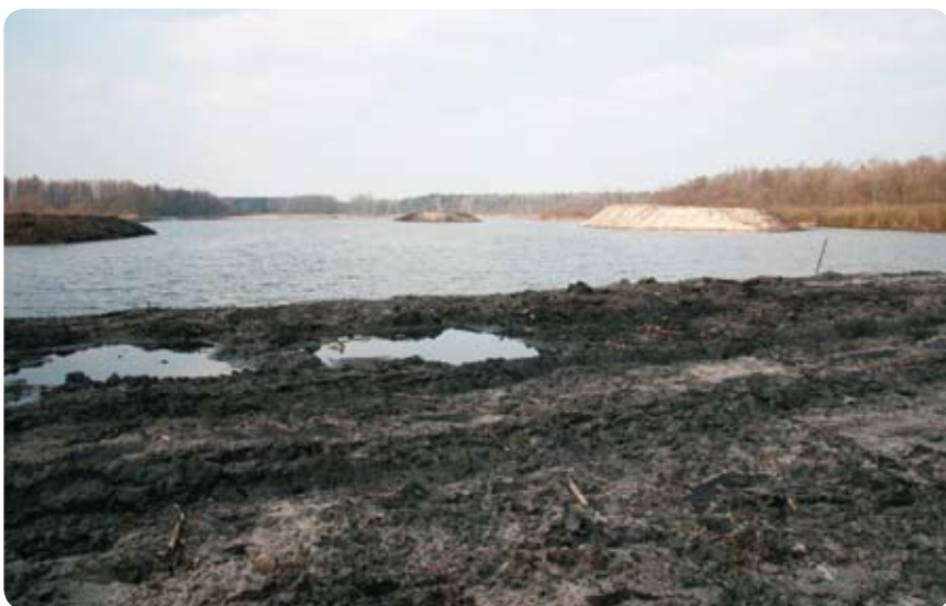
Fot. 69. Stawy tuż po wykonaniu pierwszych prac ziemnych. Widoczne już lustro wody
