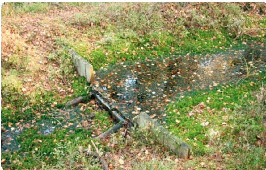
Fot. 59. Pojedyncza, prosta przegroda drewniana, stosowana do piętrzenia niewielkich rowów. Jedna z kilkudziesięciu przegród zabukowanych na torfowisku wysokim, każda z nich piętrzy wodę o kilkanaście centymetrów
