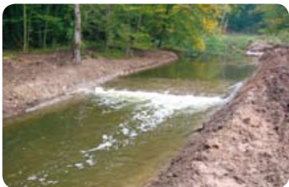
Fot. 46. Jeden z progów wybudowanych na rzece Lutyni spowalniający spływ wody i umożliwiający pobór wody do wyżej położonego rowu nawadniającego
