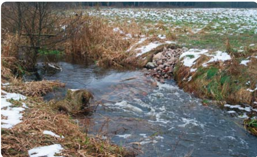
Fot. 34. Ostroga kamienna jako element służący przywracaniu naturalnego charakteru koryta rzecznego – górny odcinek rzeki Płytnicy w Nadleśnictwie Jastrowie
