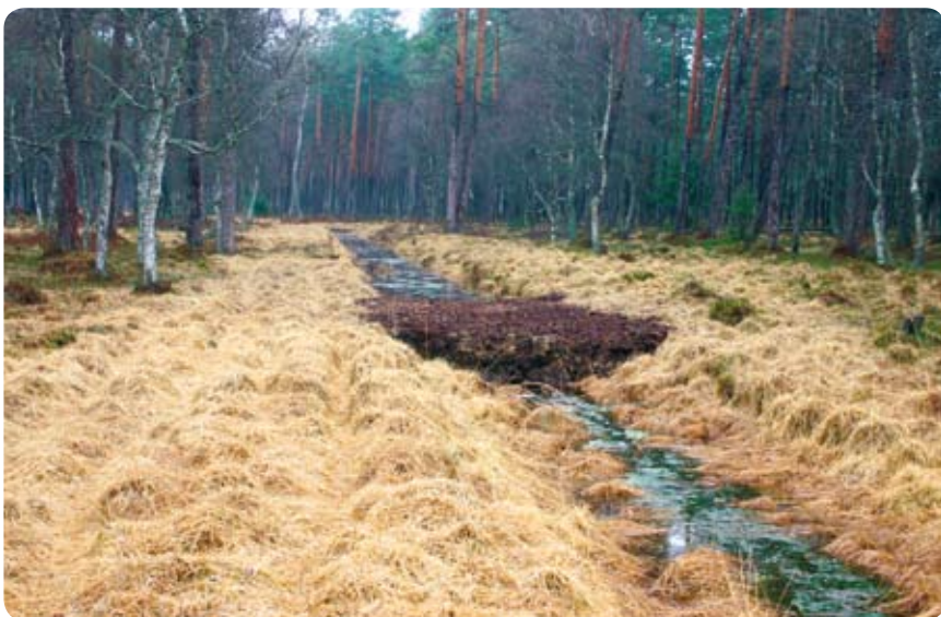
Fot. 62. Przegroda z torfu. Stosowana do blokowania rowów o minimalnym przepływie. W przypadku choćby okresowo większych przepływów, celowe jest jej wzmocnienie drewnianą ścianką szczelną
