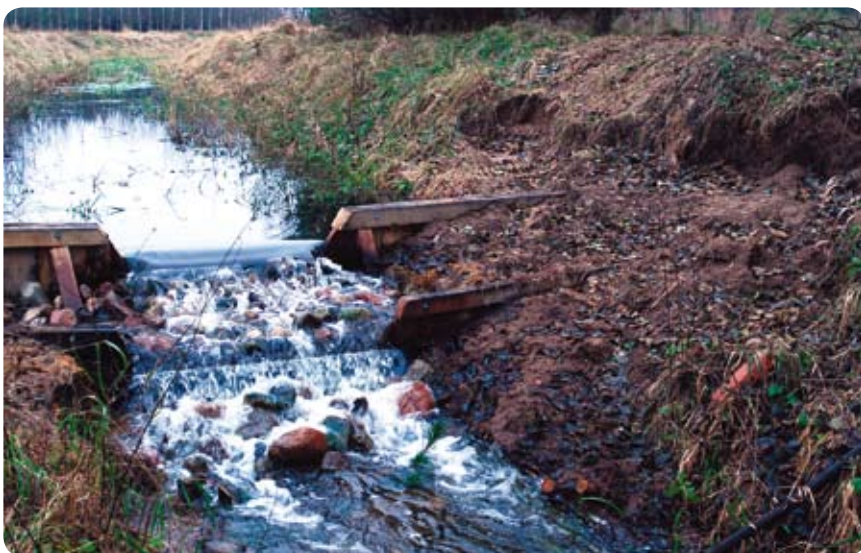
Fot. 61. Podwójna przegroda drewniana z wypełnieniem kamiennym i bystrotokiem Fot. R. Stańko
