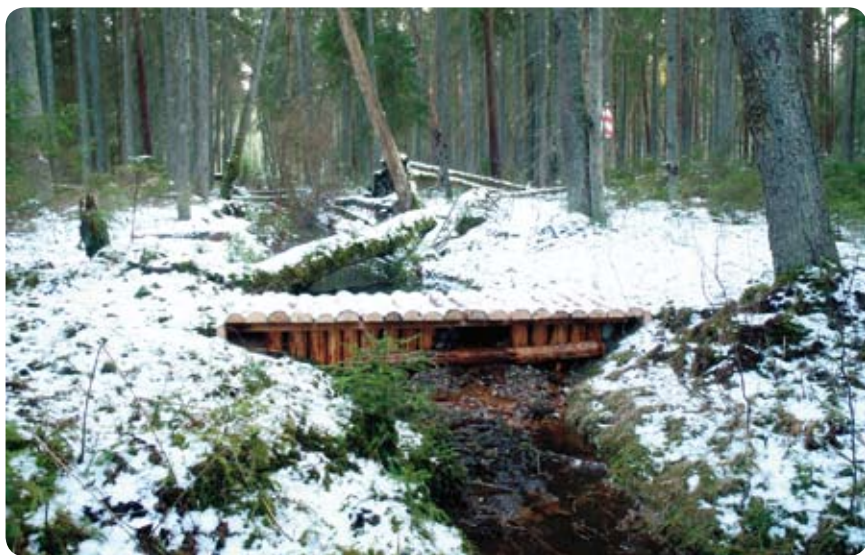
Fot. 64. Wykonana przegroda na rowie. Pośrodku niewielki przelew
