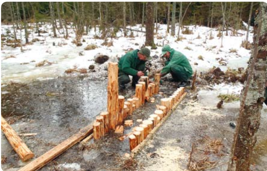
Fot. 63. Budowa przegrody z przelewem prostokątnym z wypełnieniem ziemnym
