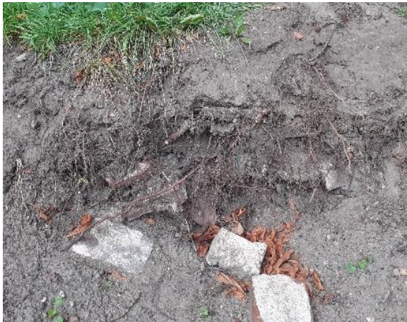
Uszkodzone drobne korzenie podczas prac budowlanych.
