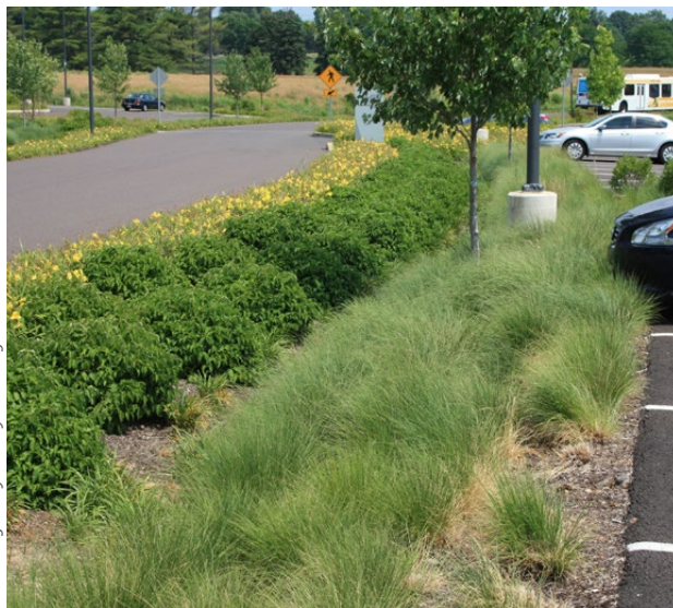
Rysunek 7. Rów infiltracyjny: East Norriton, Stany Zjednoczone (po lewej), Podkowa Leśna k. Warszawy, Polska (po prawej)
