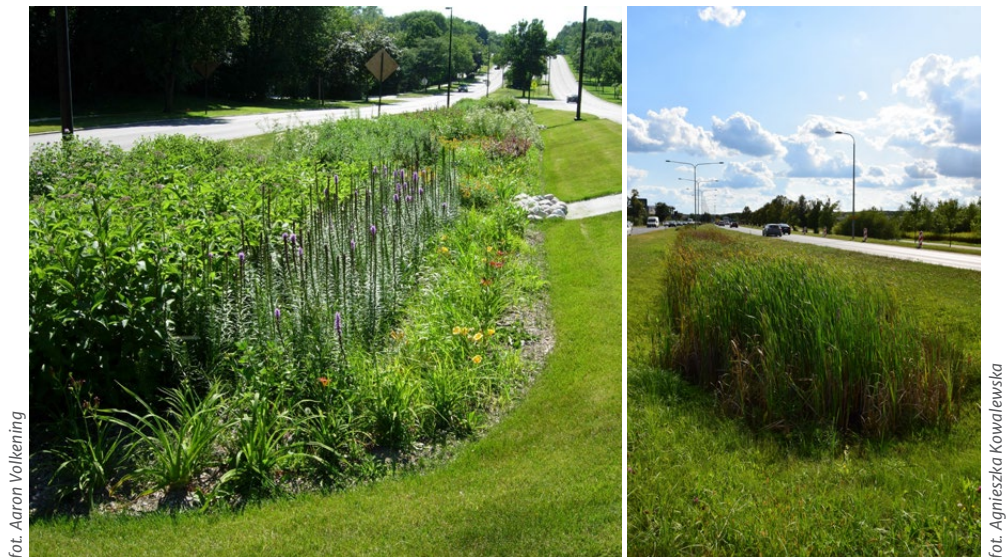
Rysunek 5. Rów bioretencyjny: Greendale, Wisconsin, Stany Zjednoczone (po lewej); Wilanów, Warszawa, Polska (po prawej)
