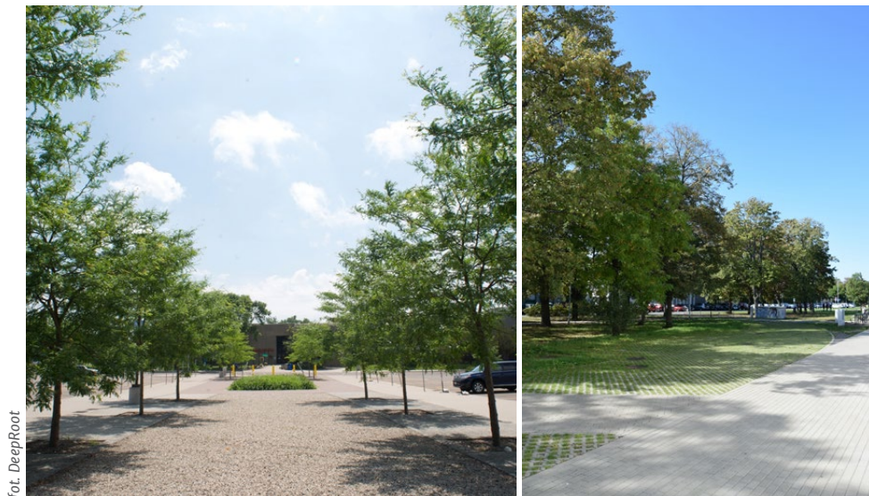
Rysunek 17. Przykłady zastosowania różnych rodzajów nawierzchni przepuszczalnych na placu przy Century College Stormwater Education Island, White Bear Lake, Stany Zjednoczone (po lewej); ażurowy parking przy Muzeum Sztuki Nowoczesnej, Warszawa, Polska (po prawej)
